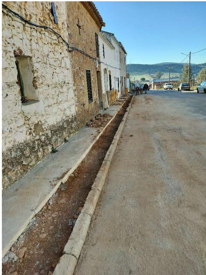
**Imagen 3. Relleno de zanja con material de excavación.**
