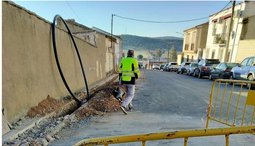
**Imagen 2. Colocación de la tubería.**
