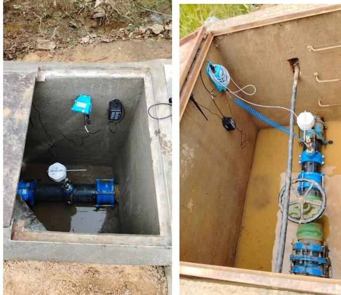
**Imagen 9. Equipos de control de calidad del agua y caudalímetros de inserción.**
