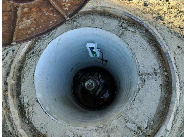
**Imagen 8. Caudalímetros con telecontrol.**
