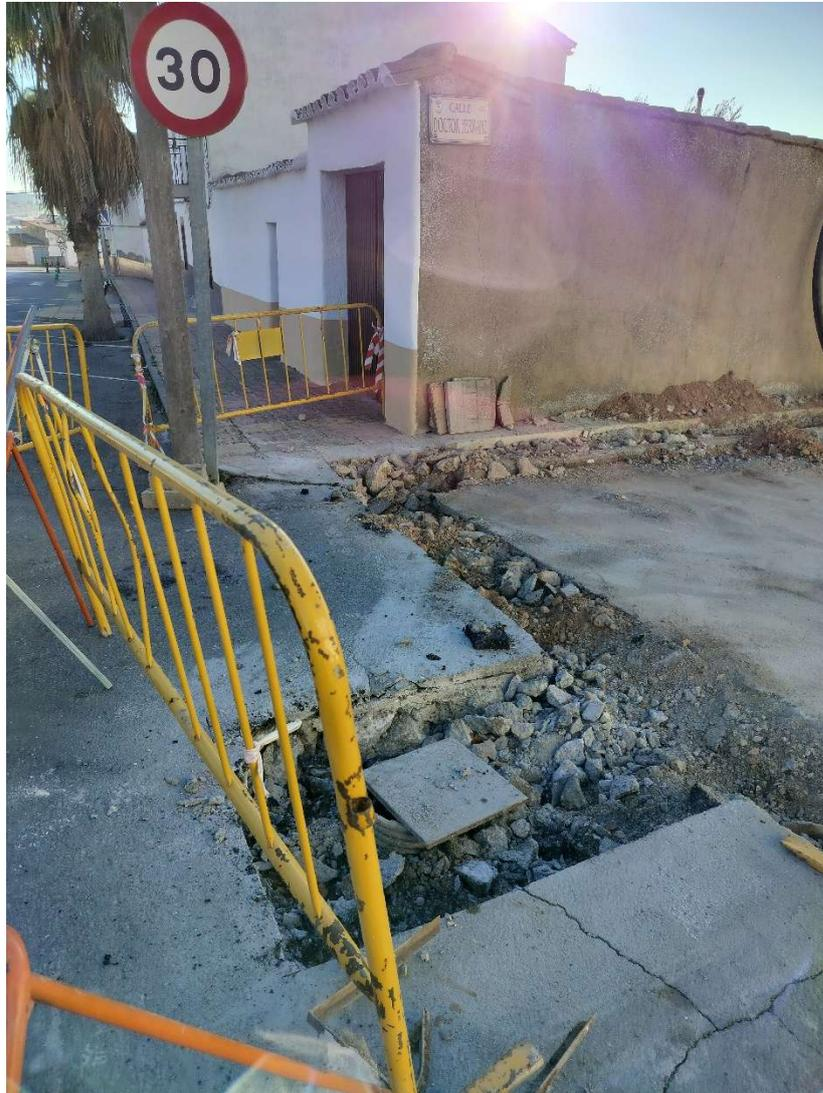
**Imagen 1. Corte y demolición de pavimento.**
