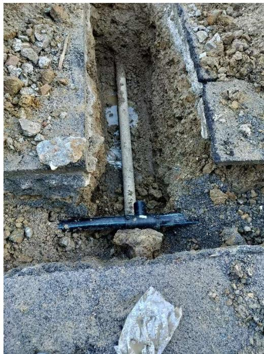
**Imagen 5. Enlaces con la tubería de fibrocemento.**
